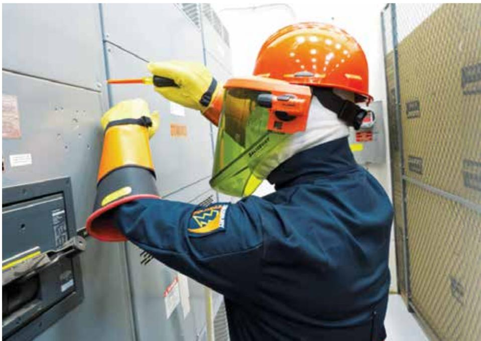
Los uniformes Salisbury poseen mecanismos retardantes contra el avance del fuego provocado por arco eléctrico.
