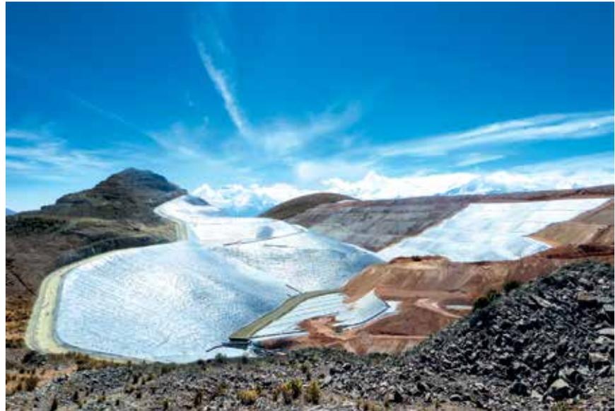
En la base del material a lixiviar se instala previamente una membrana impermeable sobre la cual se dispone un sistema de tuberías para el drenaje que permiten recoger las soluciones que se infiltran a través del material.
