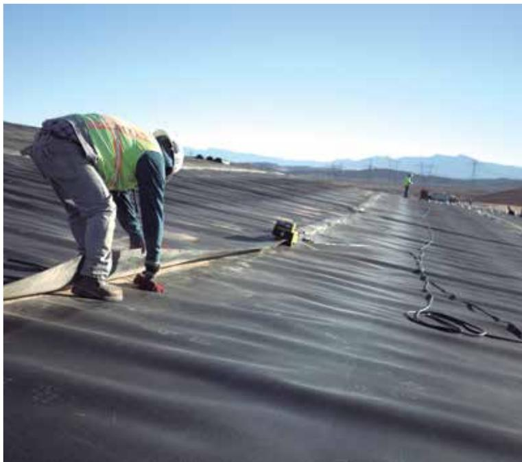
Con sumo cuidado se ejecuta el tendido y compactación de las capas revestimiento.
