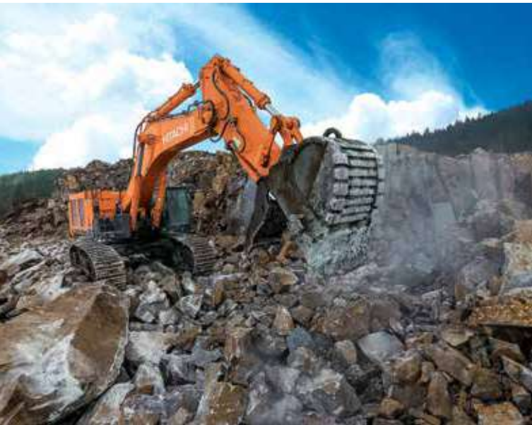
Excavadora Hitachi ZX870 LC.
