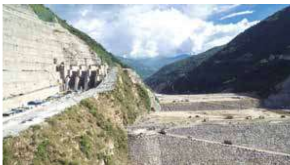
Construcción de la Central Hidroeléctrica Ituango en Antioquia - Colombia.
