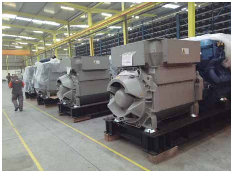
El mantenimiento del equipo electrógeno se realiza 250 horas o 6 meses, dependiendo de su aplicación.
