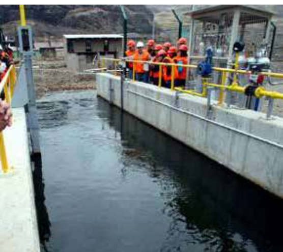
Minera Chinalco invirtió más de US$ 44 millones en el proyecto de la Planta de Tratamiento de Aguas Ácidas del Túnel Kingsmill, ubicada en Junín.
