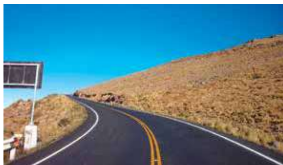
Mantenimiento Periódico de la Carretera Pisco - Ayacucho.
