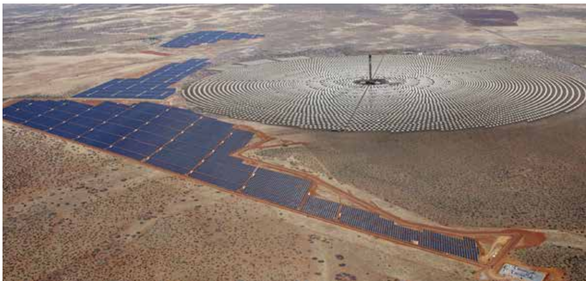
Las mineras están recurriendo a las energías renovables para generar energía limpia.
