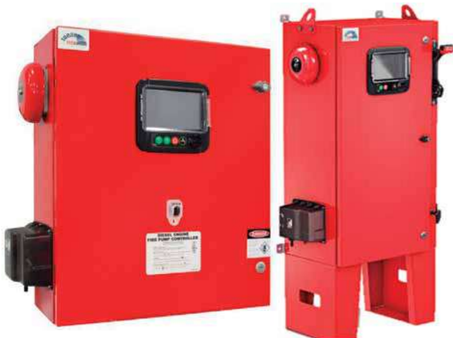
Los tableros de control son una herramienta indispensable para manipular los equipos contra fuego.
