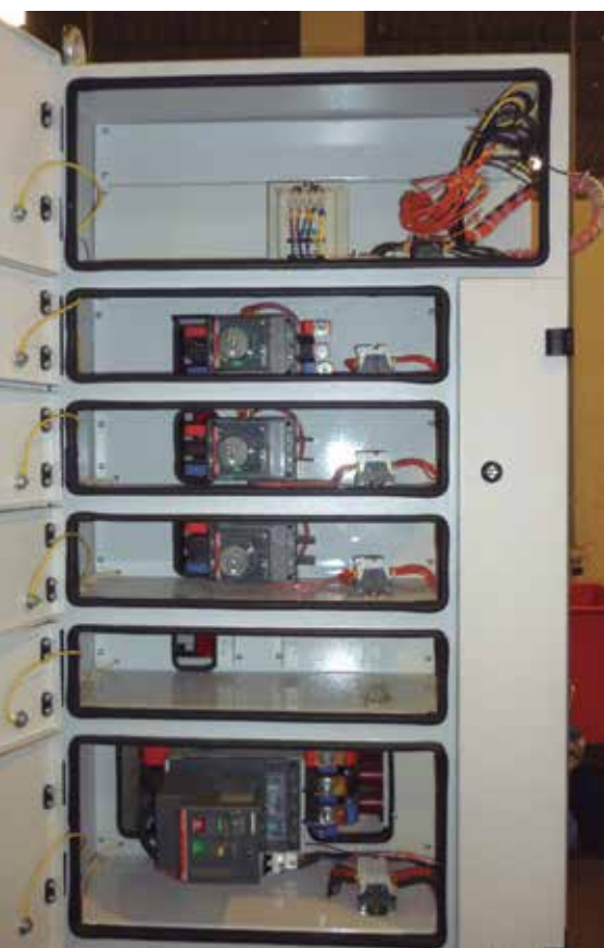
“La implementación de tableros eléctricos es vital para la continuidad de las operaciones mineras”, afirmó Abdul Carrillo.
