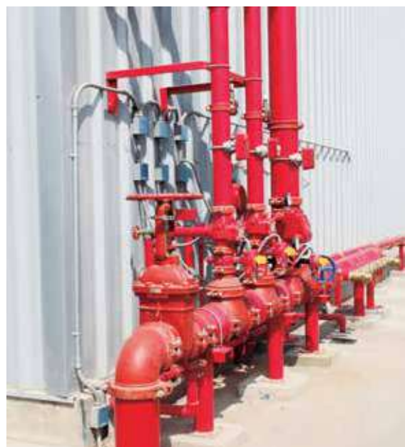
JRM posee equipos de detección y extinción de incendios.
