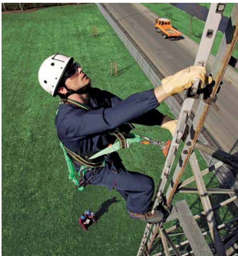
Los equipos de protección deben cumplir con las estipulaciones de la norma ANSI.
