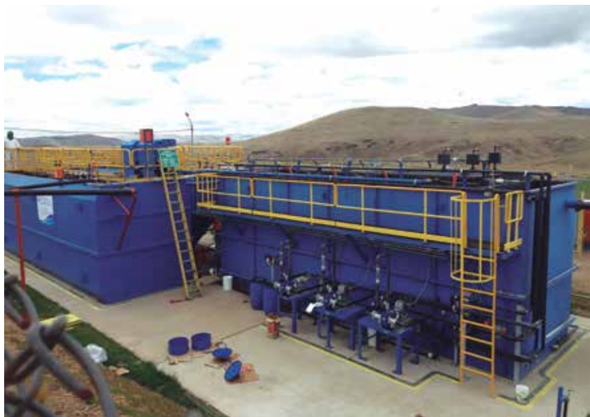
La empresa cuenta, en su portafolio, con tecnología para el tratamiento de aguas residuales.
