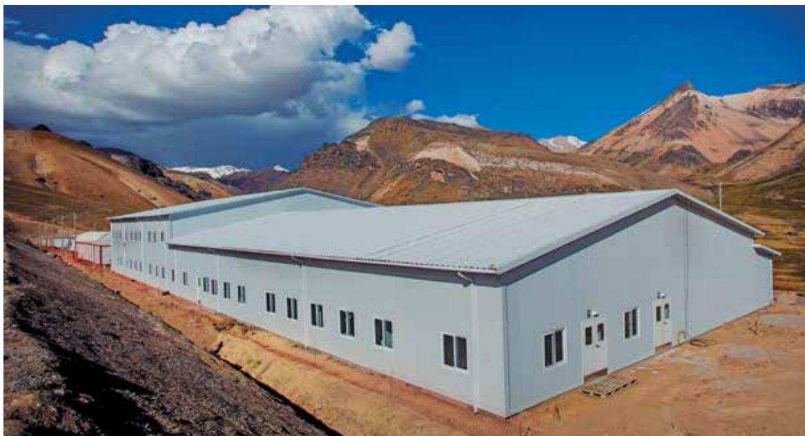
Desde Galvec cuentan que de una empresa requerir una estructura liviana, recomiendan usar láminas de acero prepintadas con pintura epóxica de 0.5 milímetros de espesor.
