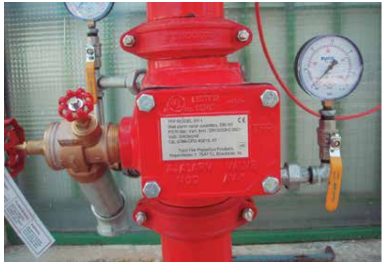
El accionamiento a tiempo de los equipos contraincendio pueden salvar los activos más importantes de la empresa.
