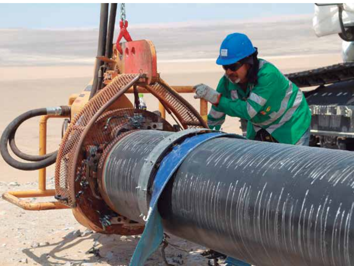
Los tubos y mangueras son elementos omnipresentes en la minería moderna e insumos determinantes para la actividad.
