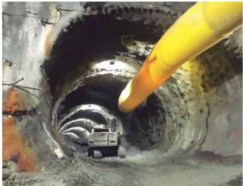
Los ductos de ventilación son parte de los productos del mercado.
