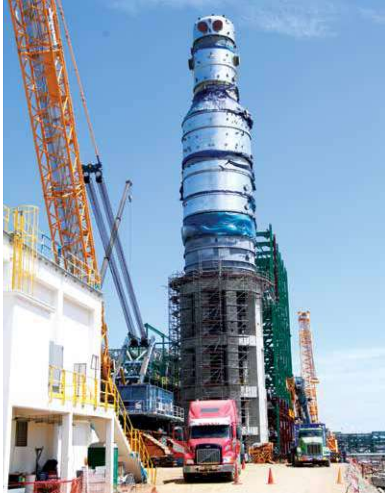
Las unidades de proceso de la nueva refinería de Talara avanzan al 80%.
