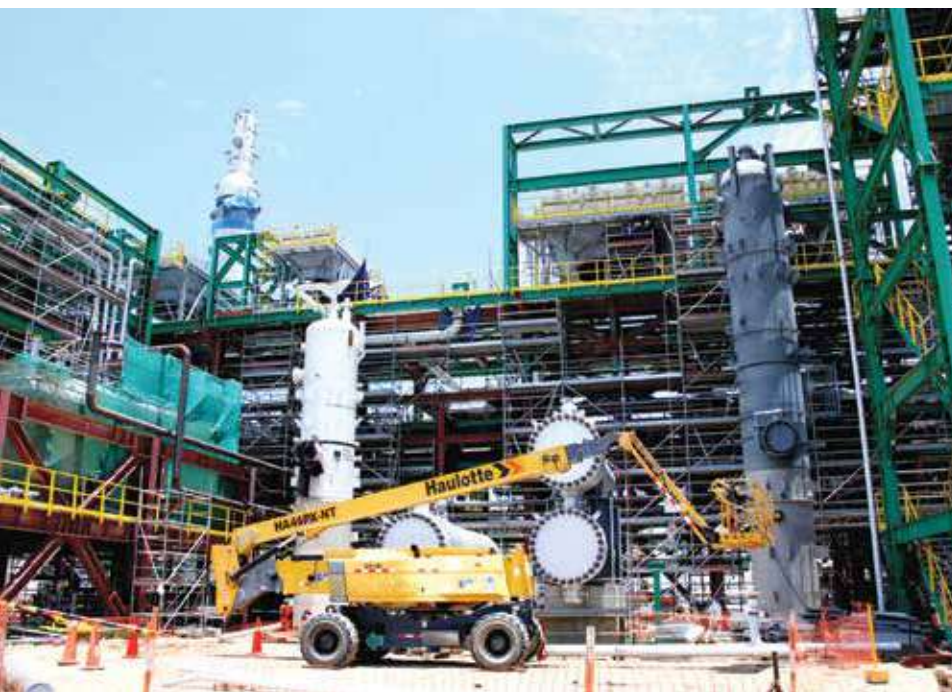
La modernización de la Refinería de Talara presenta un avance del 70%.
