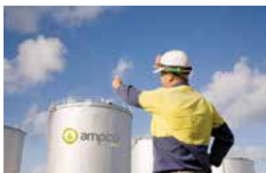
Planta de tratamiento
