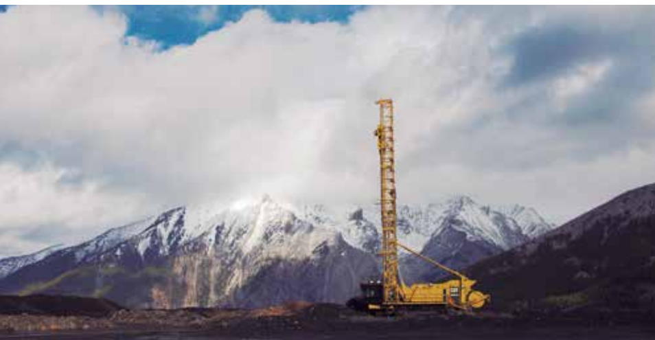
La perforadora CAT MD6640 optimiza los ratios de perforación y nivelación.
