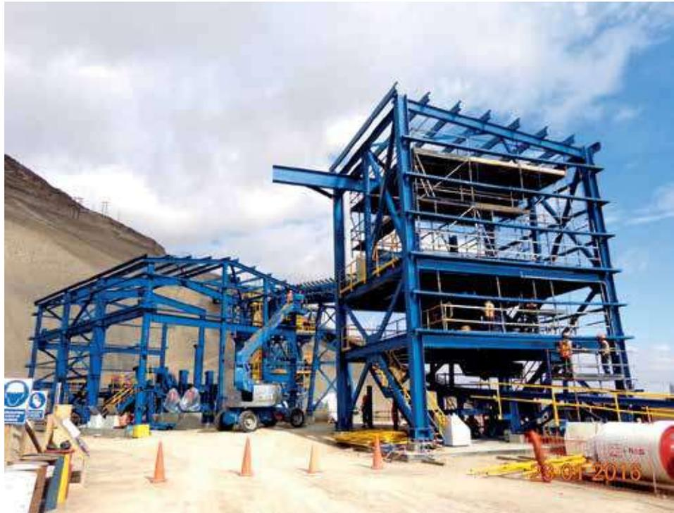
Los elementos de la estructura se entregan pre-armados en taller, para facilitar el montaje final, el cual se realiza mediante conexiones empernadas o soldadas.
