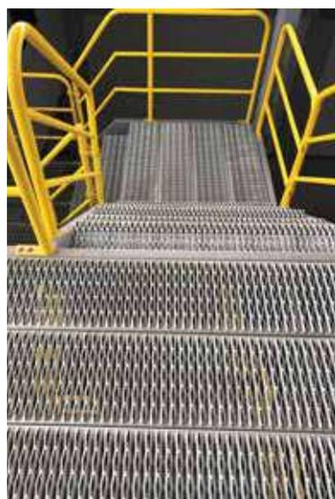
La Rejilla Tipo Grip Strut es un producto industrial fabricado por PROSOLDES y es hecho de una sola pieza (placa). Su superficie presenta aberturas en forma de rombos con bordes dentados que brindan alta resistencia antideslizante en cualquier dirección y bajo distintas condiciones de uso (cuando está seca, con grasa, barro, jabonosa o con hielo).
