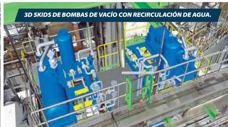
**3D SKIDS DE BOMBAS DE VACÍO CON RECIRCULACIÓN DE AGUA.**
