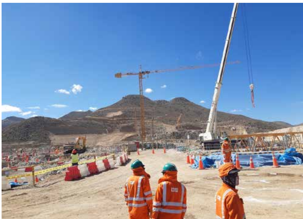
Las grúas torre se han convertido en el mejor aliado para el movimiento de elementos de gran peso y tamaño.
