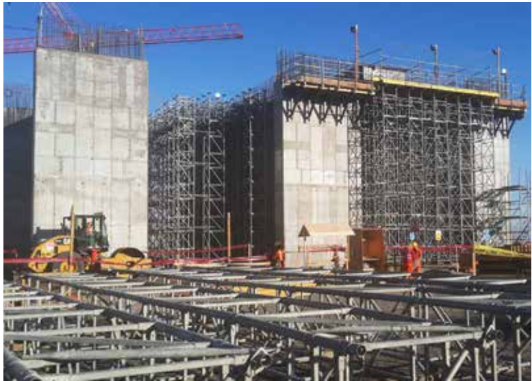
La PTAR La Tomilla II se construyó en el distrito de Cayma, ciudad de Arequipa, a 2800 m.s.n.m.
