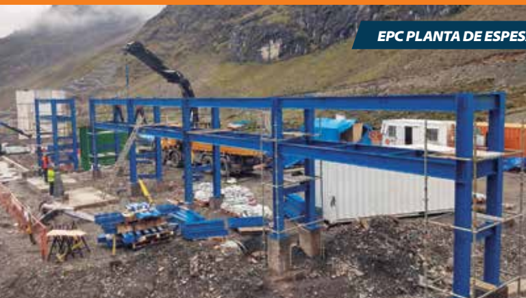
SISTEMA DE ALMACENAMIENTO DE ÁCIDO SULFÚRICO
