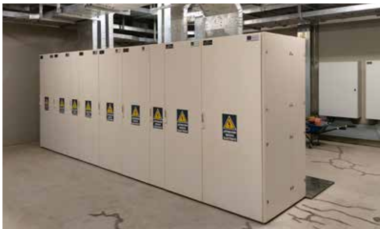
Vista de un Tablero Protocolizado del Patio de Cocheras de la Línea 2 del Metro Lima.
