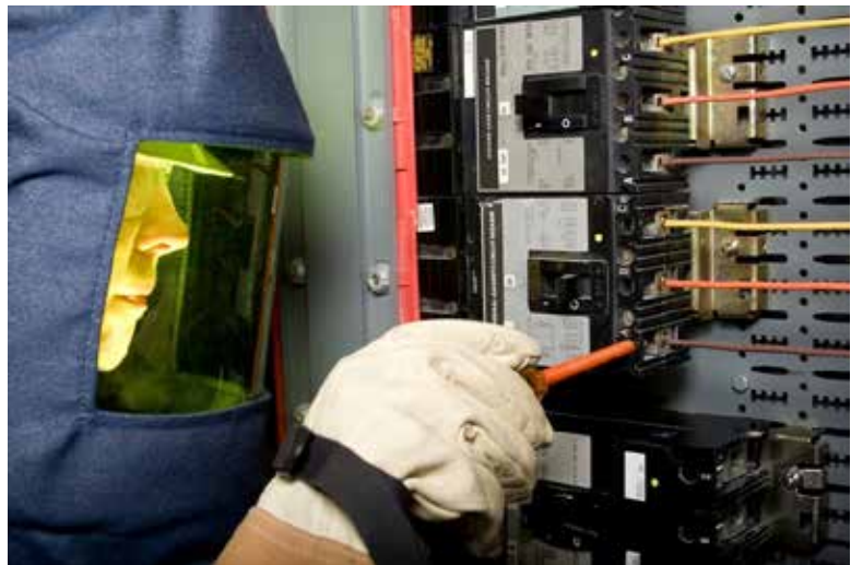
Los cables eléctricos se encargan de soportar el peso del paso de la energía eléctrica en las operaciones mineras
